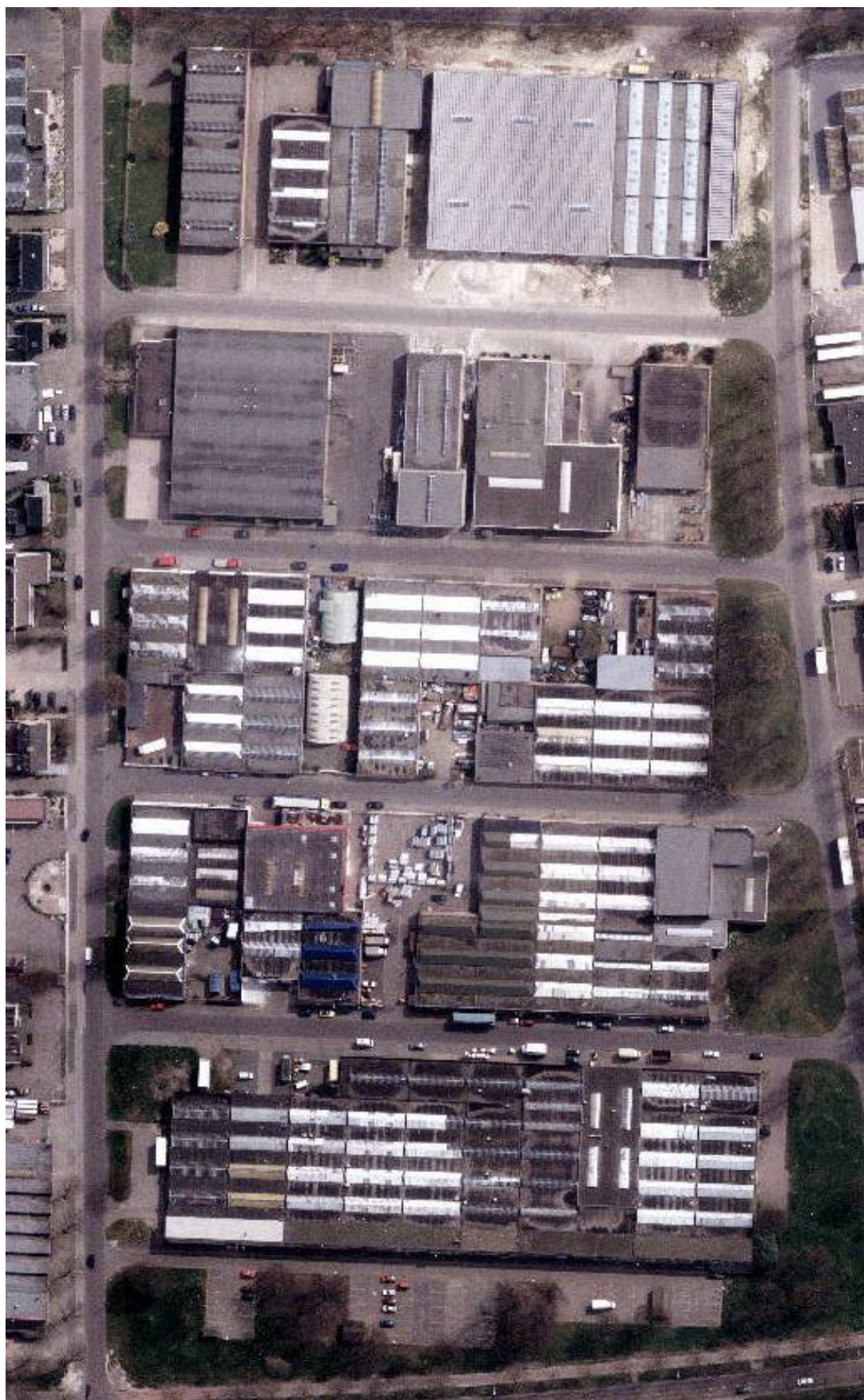
Luchtfoto plangebied Induma Oost bestaande toestand
