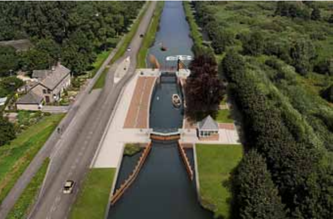
De inmiddels gerenoveerde sluis 7 in de Zuid-willemsvaart in Helmond
