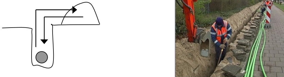
Figuur 3.2: Werkzaamheden kabels en leidingen
