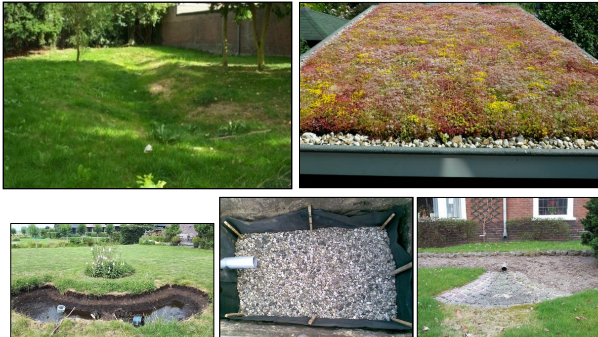
Figuur 23: Voorbeelden infiltratievoorzieningen
